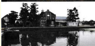
上) 浄水場建設現場 下) 建設後の浄水場 (現在は水がありません)
